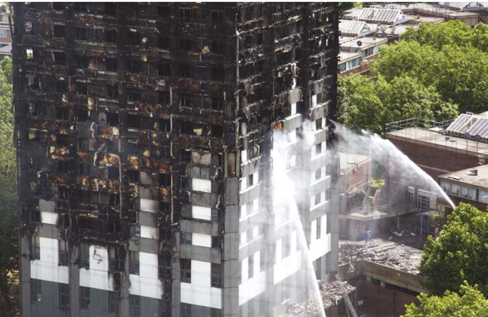
Imagem da edificação incendiada e o seu entorno, que dificultou ainda mais as ações de combate
